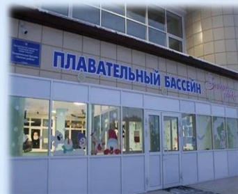
Плавательный бассейн «Золотая рыбка». В 2019 году проведен капитальный ремонт
